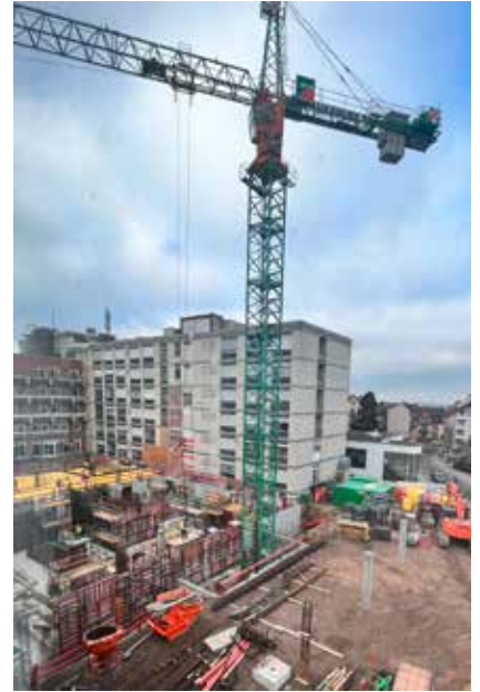
Die Wände im Untergeschoss werden hochgezogen.
