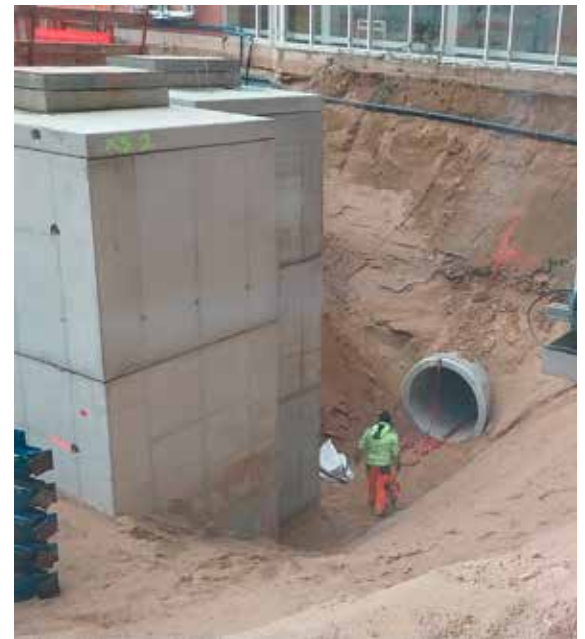
Durch die Leerrohre werden die Kabel geführt.
