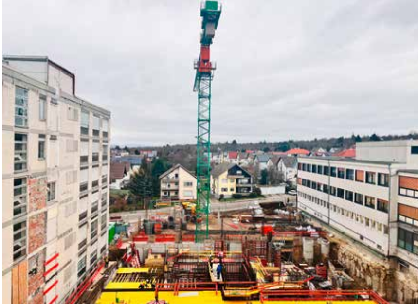
Die Fundamente und die Bodenplatte sind gelegt.
