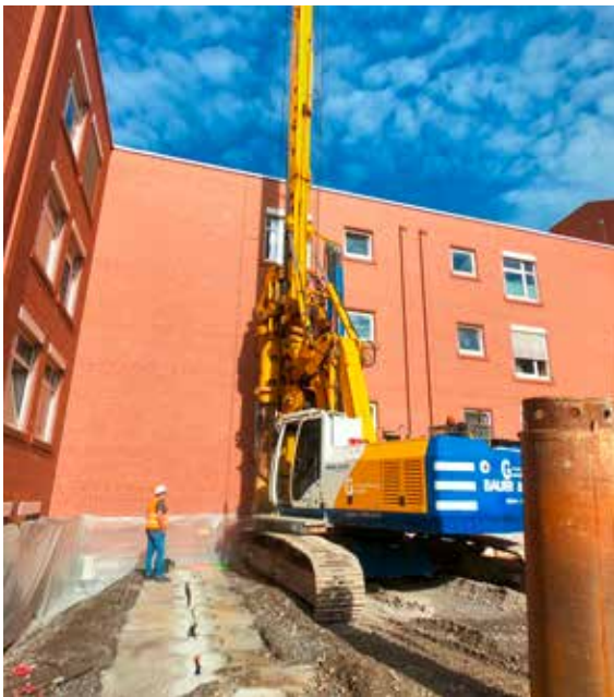
Herstellung der Pressgrube.
