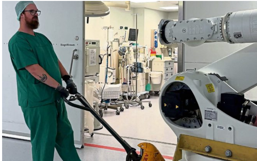
Die alte Anlage musste bei laufendem OP-Betrieb entfernt werden. Foto: RKH Gesundheit
