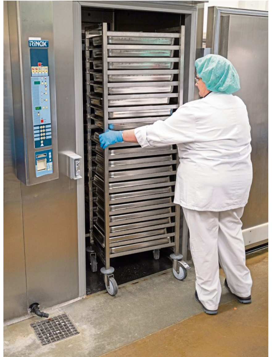
Innerhalb von 90 Minuten wird das Essen auf sieben Grad gekühlt.
